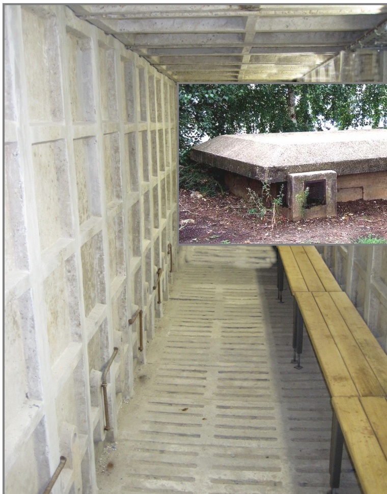
Entrée et intérieur d'un abri-tranchée amélioré par des panneaux de béton préfabriqués – Lyon 8
