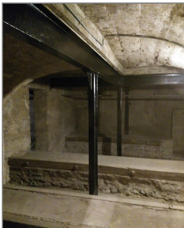
Cave à étais métalliques servant d'abri au lycée Ampère
