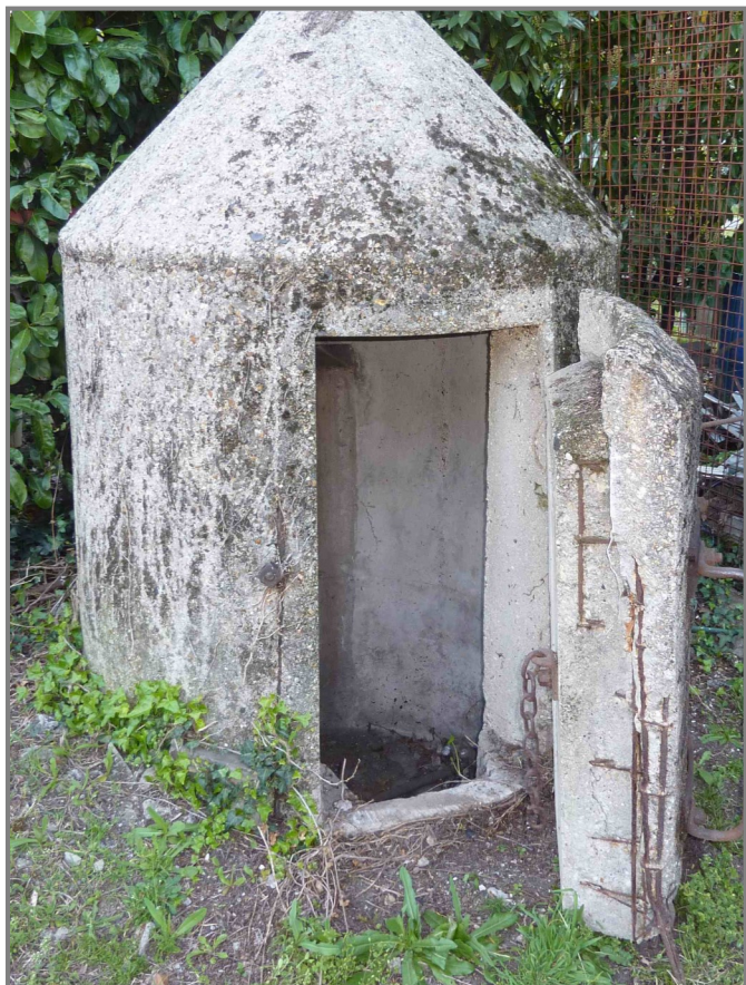
Abri individuel, de construction allemande, en bordure de la gare de triage de Saint - Germain -au - Mont - d'Or
