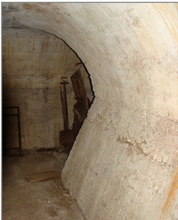
Abri creusé et bétonné dans un terrain en pente et arboré du centre ville de Saint - Germain - au - Mont - d'Or, destiné aux élèves des écoles voisines.
