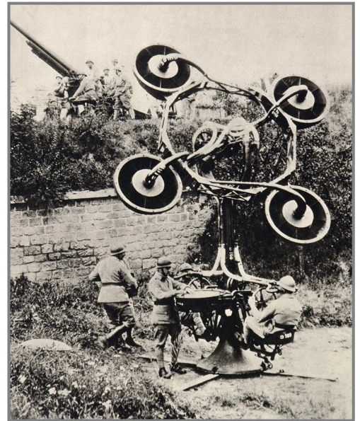
Système Perrin (Jean – Baptiste) expérimenté en 1918 construit à 10 exemplaires. portée 6000 m pour un avion à 2000 m d'altitude
